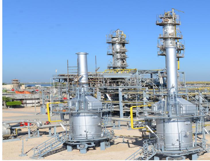
(أنوبك)، ويتضمن المشروع تركيب وحدات لاسترجاع الطاقة المهدرة (Waste Heat Recovery) وتوليد الكهرباء بقدرة ٢٤ ميغاوات دون أى استهلاك إضافى للوقود وهو ما يؤدى لخفض الانبعاثات الكربونية بفضل عملية استعادة الحرارة من عوادم التربينات الغازية حيث تم الانتهاء من ٩١٪ من حجم الأعمال.
