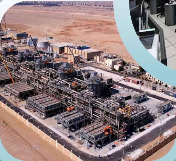
مشروع توسعات محطة ضواغط، دهشور
